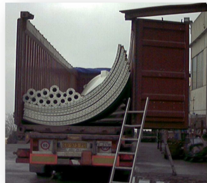
TRASPORTO VIA MARE N.1 Silo 8CS5 con accessori in due container 40' OT
