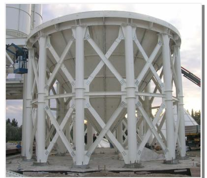
N.4 silos,  $\varnothing$  9210 mm, con capacità 1480 m<sup>3</sup> e scarico a 1500 mm da terra; tutti i silos dotati di filtri depolveratori a maniche in inox, da 40 m<sup>2</sup> ed aspiratore da 5,5 KW; sili completi di scale, parapetti, tubi di carico, valvole di sicurezza, indicatori di livello e valvole di intercettazione; sistema di estrazione a canalette fluidificanti, ciascuno dei quali composto da 1 anelli da 12 canalette, sezione 250x3000 mm;
